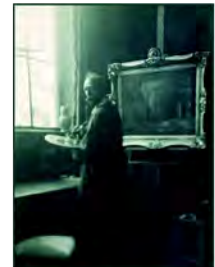
In der Atelierwohnung Hohenzollerstraße 5
